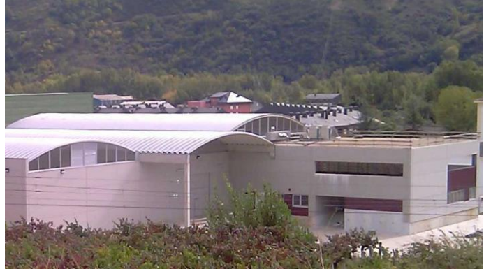
Instalaciones de la compañía CEDIE en Ourense
